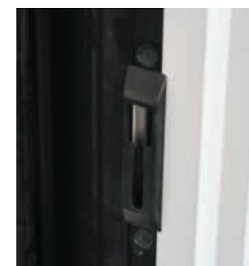
(1) Verrouillage sur le dormant
